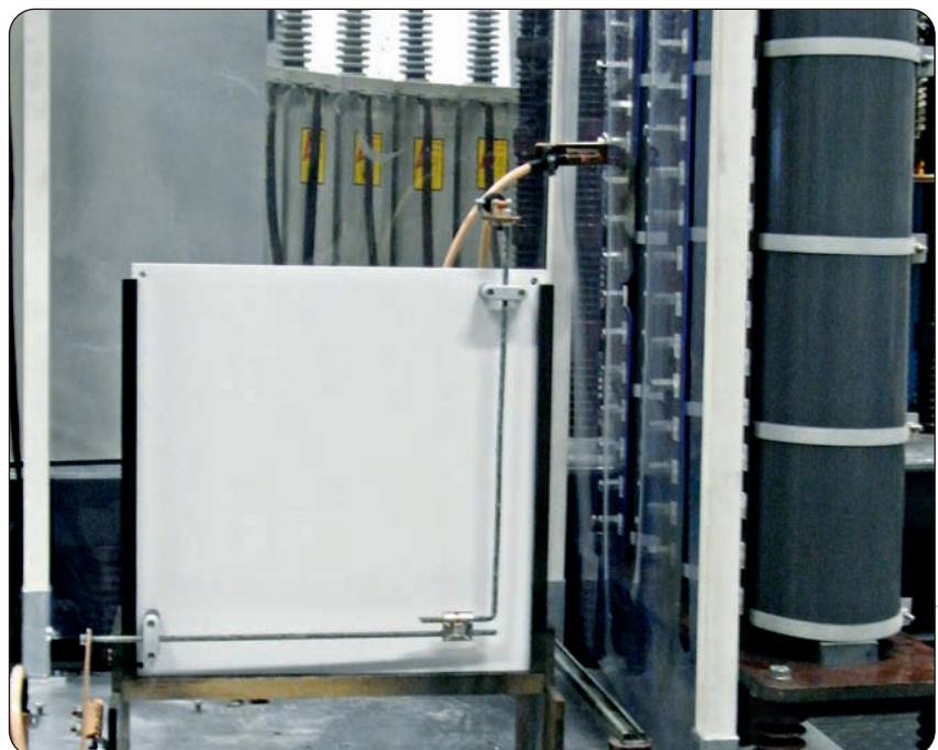
Fig. 5: Echantillon fixé à une plaque isolante (borne MV) pour le test dans le laboratoire de décharges électriques
