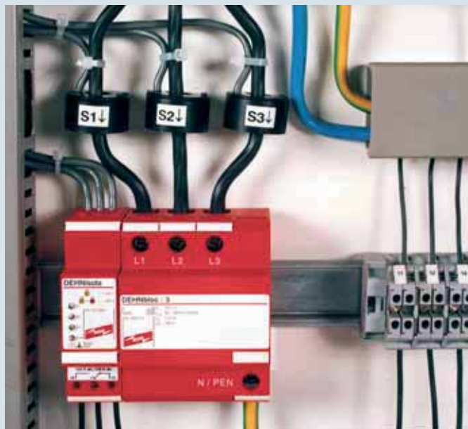
Test permanent du fonctionnement de parafoudres et de parasurtenseurs installés au moyen de l'installation de surveillance DEHNisola.
