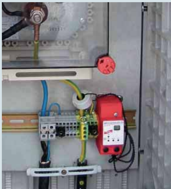
Compteur avec alimentation par batterie intégrée (9 V) et contrôle de l'état de charge. Indication par afficheur LCD à 2 positions et boutons-poussoirs de réglage et de remise à zéro.
