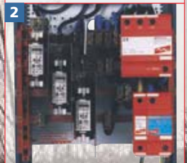
DEHNbloc®/3 et DEHNgap B/n dans le coffret du compteur
