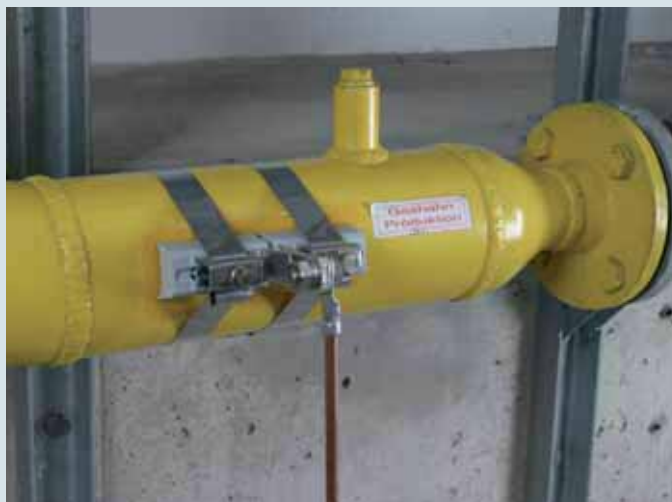
Collier de serrage pour assurer le contact électrique de tuyaux dans des zones à risque d'explosion, en application de l'équilibrage de potentiel pour la protection contre la foudre selon DIN EN 62305-3 (VDE 0185-305-3)
