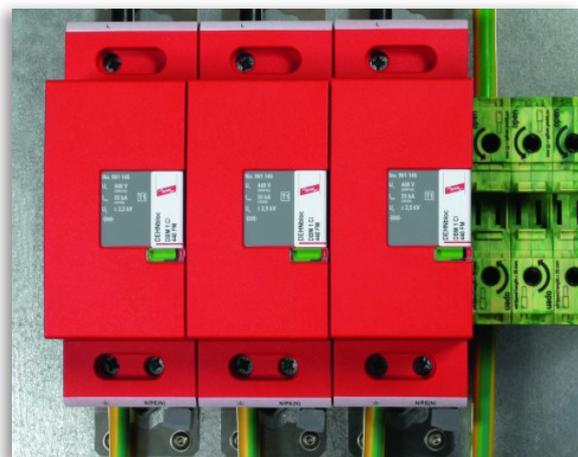
Les parafoudres coordonnés DEHNbloc Maxi 440 et 760 ont été spécialement conçus pour des systèmes avec des tensions élevées et protègent les installations contre les courants de foudre directs et les surtensions.
