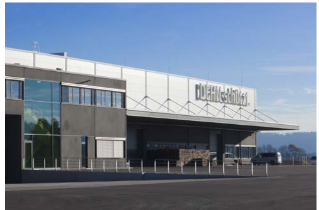
Installations tertiaires et industrielles
