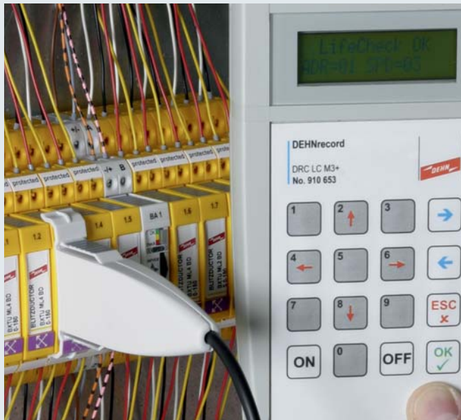
Test d'un module parafoudre avec la technologie RFID (LifeCheck)
