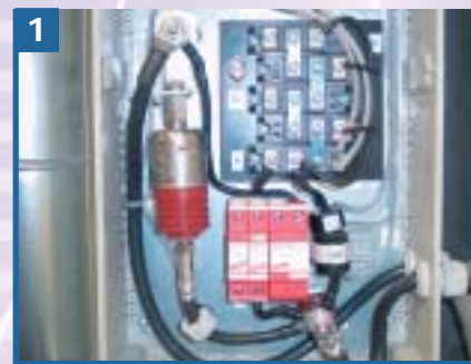
VCSD 30 dispositif de mise en court-circuit, à tension asservie Référence 989 400/S N° de série 4329
